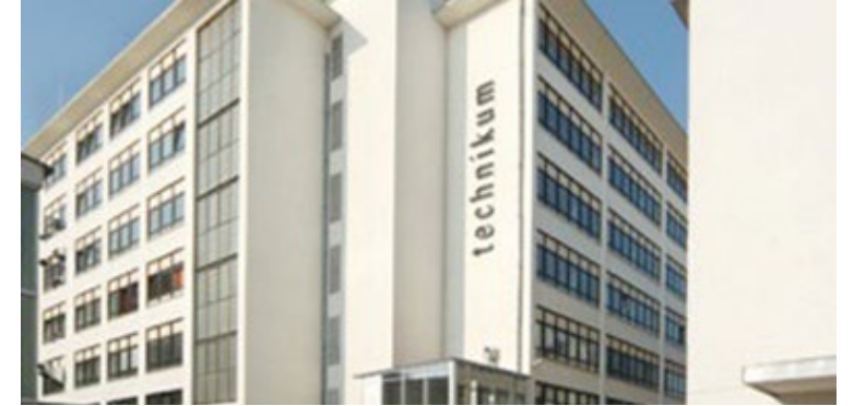
Grundig Areal / Uferstadt
