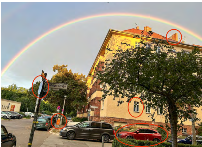
Original mit Fehlerkennzeichnung
