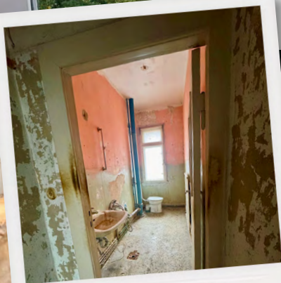
Wohnungsherrichtung zur Wiedervermietung
